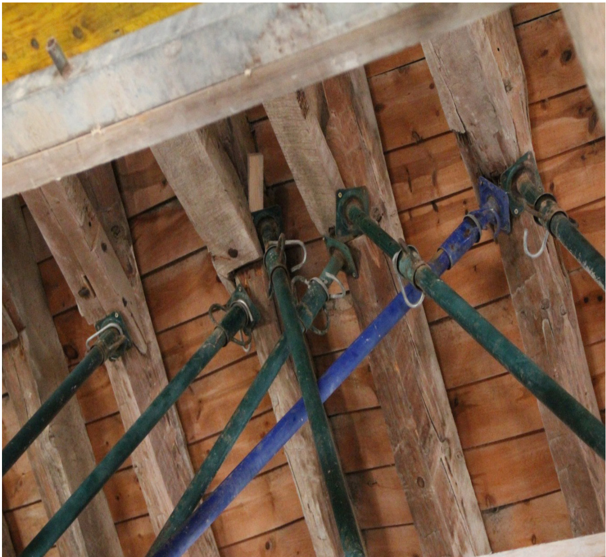
Puntales instalados en 2022 para evitar el derrumbe de la cubierta
