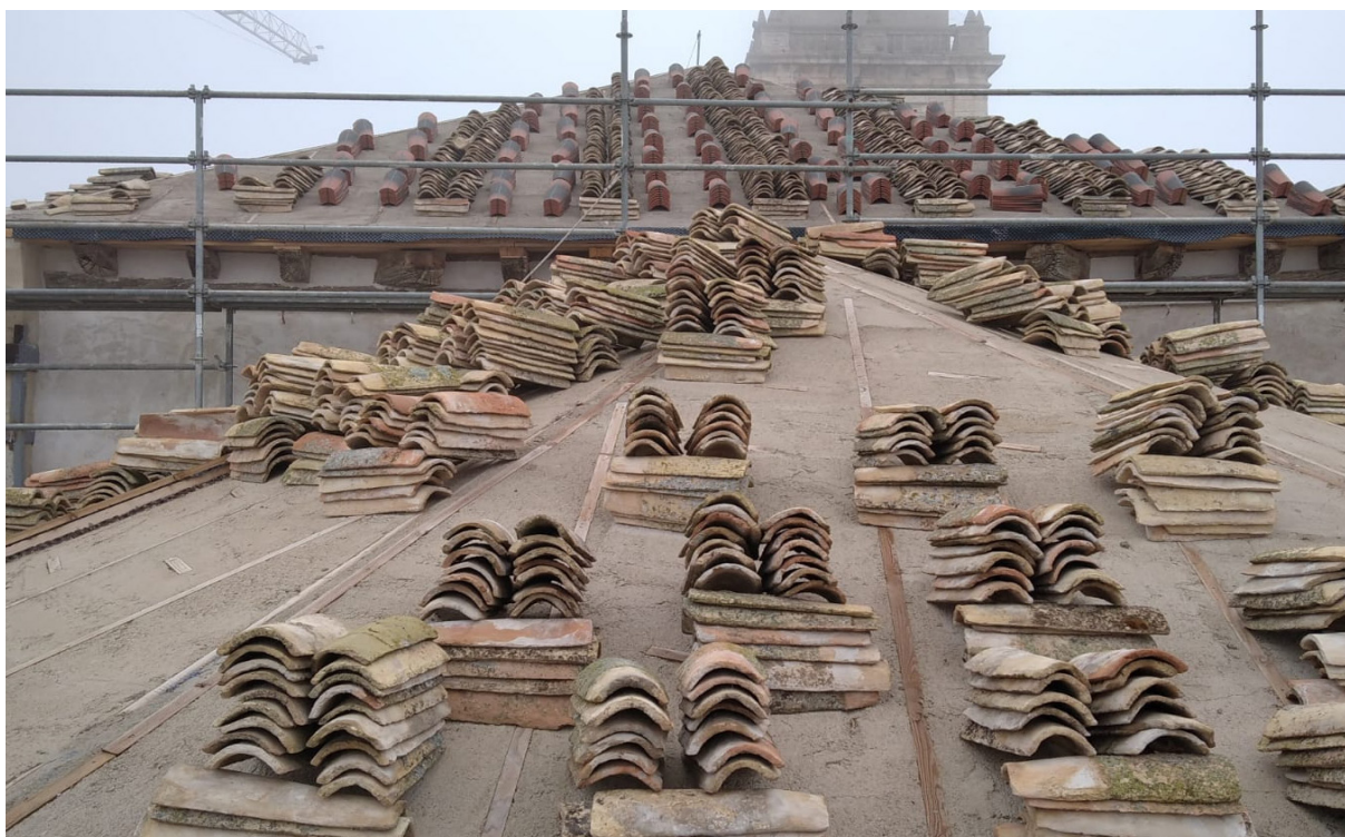
Imágenes con el inicio de las obras gracias a los donativos y financiación del Arzobispado de Toledo
